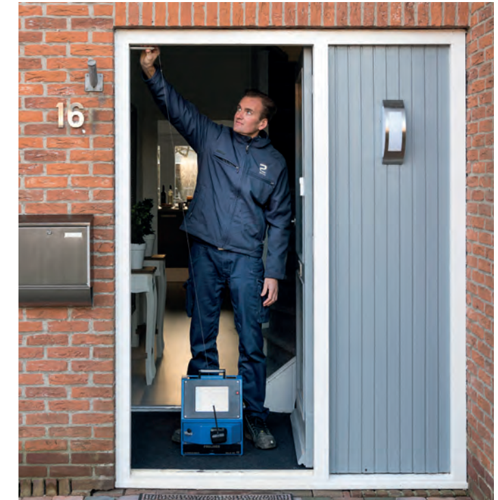
De Zadore monteur meet het kozijn nauwkeurig na
